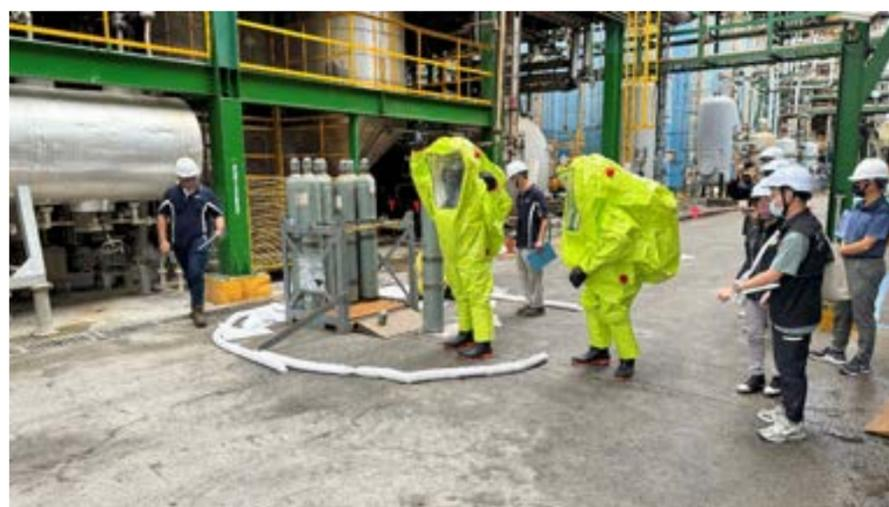
說明：操作組人員著A級防護衣，進行氣體鋼瓶閥座洩漏點止漏作業
