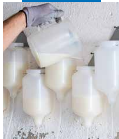
在擴散杯倒入 Mapestop混合物
