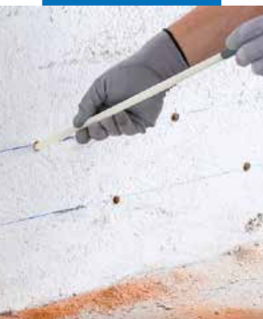
插入注射管至牆面孔
