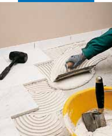
安裝 卡拉拉大理石 搭 配白色 Granirapid
