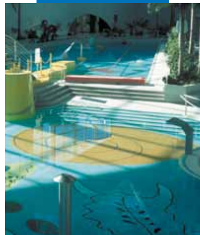
泳池安裝馬賽克、鋼磚
