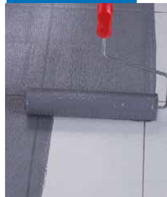
在舊瓷磚面以滾筒滾塗Eco Prim Grip
