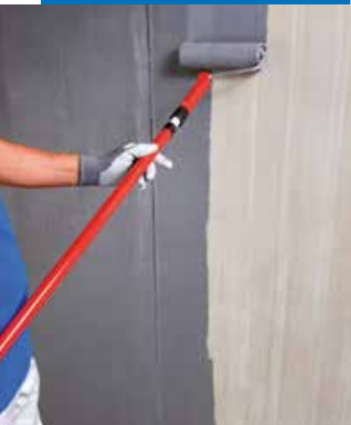
以滾筒將Eco Prim Grip Plus施作在混凝土牆面
