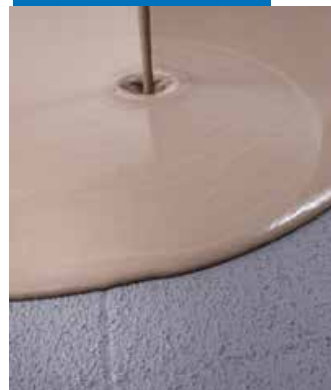
在舊地板上的Eco Prim Grip Plus完成面施作平滑面砂漿
