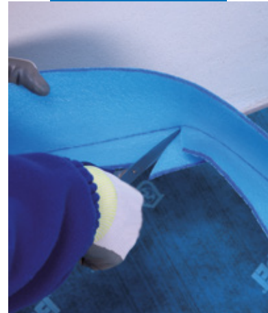
剪切Mapesilent Band R底部多餘的部分至90° 度角
