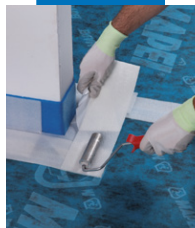
剪切修飾，在所有Mapesilent Band R及Mapesilent Roll邊角黏貼Mapesilent Tape繃帶，確保Mapesilent Band R 縫完全覆蓋
