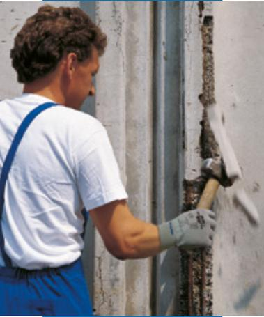
拆除退化混凝土
