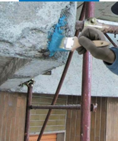
將Mapefer 1K塗刷鋼筋混凝土陽台的鋼筋上
