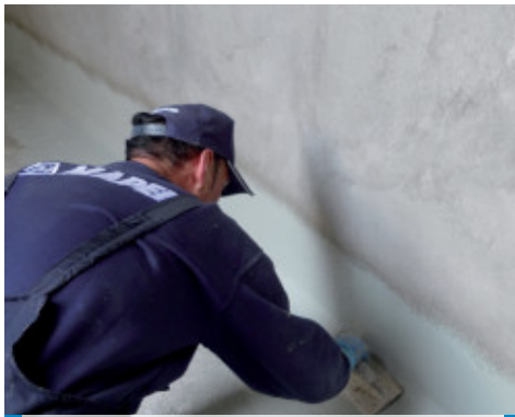
鏟塗Mapelastic Foundation防水砂漿，因應負水壓
