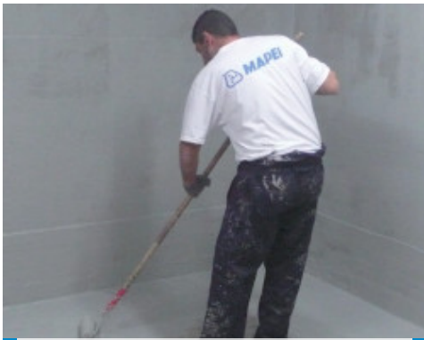
長柄滾筒塗佈Mapelastic Foundation防水砂漿，因應負水壓
