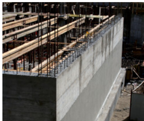
擋土牆澆築 Mapelastic Foundation 防水
