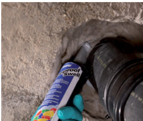
穿透混凝土的結構件以 Maeproof Swell 防水密封膠密封
