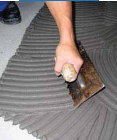
鋪貼磁磚: 以方齒鏟刀鍍 塗黏著劑在基底上 *不得一次施做大於1m 2 .
