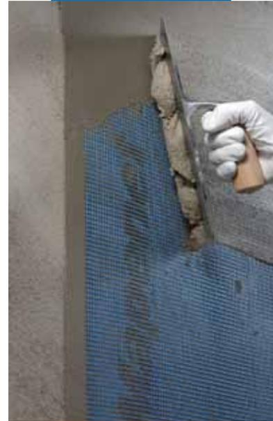
異材質基底上 Planitop 200加裝 Mapenet 150不織布，圖示為第二層 Planitop 200施作
