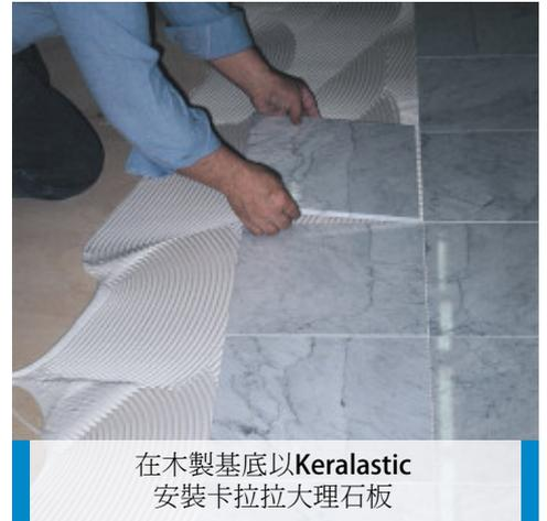
在木製基底以Keralastic安裝卡拉拉大理石板
