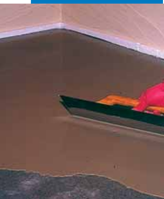
以金屬鏟刀施作 Novoplan 21在經過 Primer G打底的水泥 砂漿面
