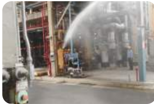
滅火班以水霧掩護人員進災區進行隔離作業
