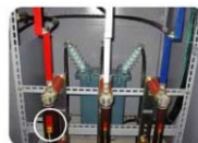
高壓保險絲過載異常溫度偵測
