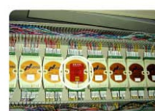
通信環控室異常溫度偵測
